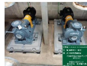
県立美術館 ポンプ据付工事
