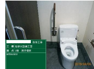
A病院給排水設備工事
