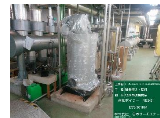
県立美術館 蒸気ボイラー据付工事
