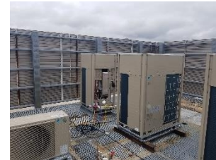
某銀行 空調設備更新工事
